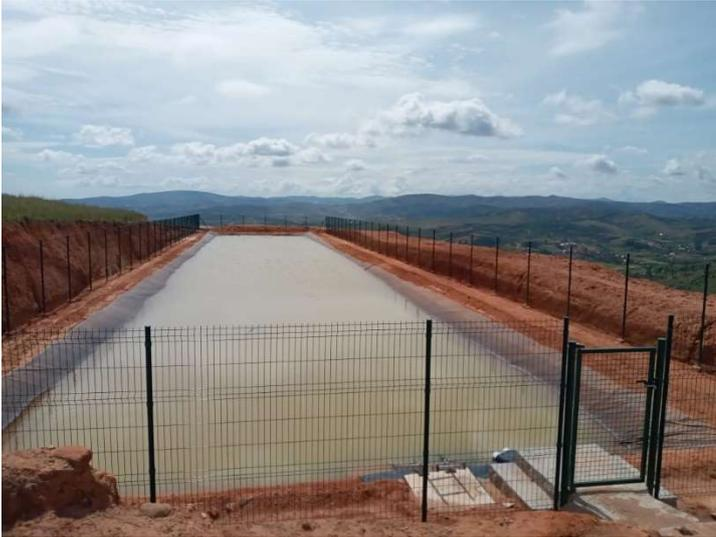
**QUOI :** Système de récupération d'eau de pluie par canaux de ruissellement creusé à flanc de colline et de transport vers des grands réservoirs (retenue collinaire) étanchéifiés, équipé d'un système d'exhaure pour distribuer l'eau sur les cultures et ou villages en contre-bas.
