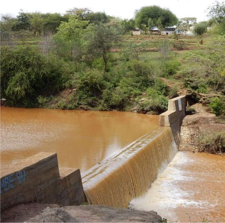
**QUOI :** Système de stockage d'eau de rivière avec protection des pertes par évaporation grâce aux sables alluvionneux retenus en amont du barrage.
