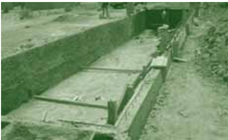
Chantier de construction d'un bassin de lagunage à Ouagadougou au Burkina Faso
