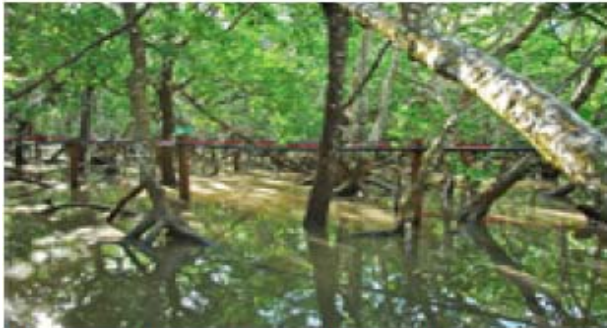
Le système de conduite et de rejet des eaux usées en mangrove, à marée haute.
