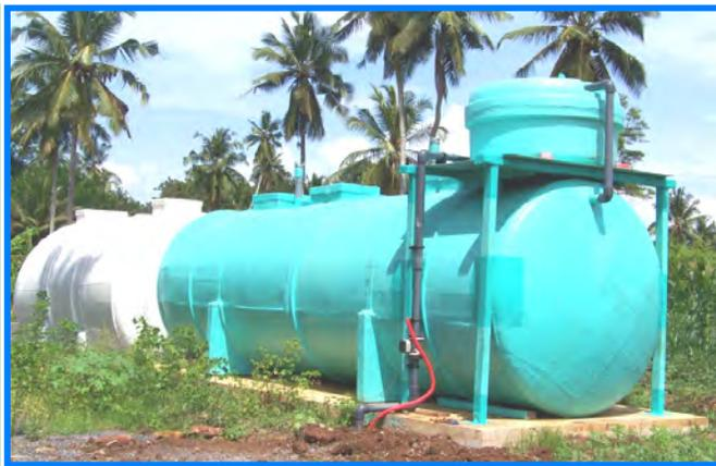
*Décanteur et cuve-tampon*
