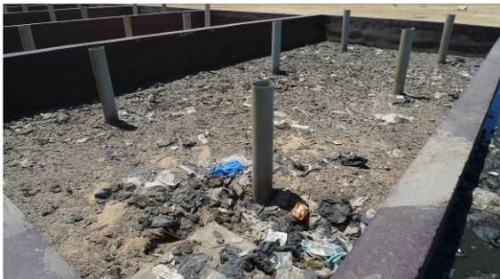
Présence de déchets solides sur lits de séchage => dégrillage à réaliser
