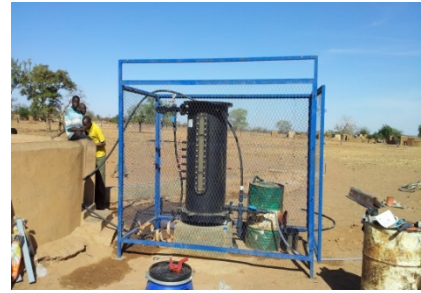
(c) installation sur site
