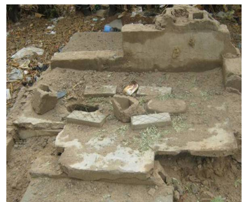
Ruine d'une VIP à Richard Toll (ZP4)
