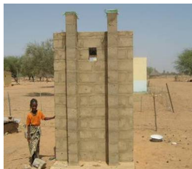
VIP double fosse réalisée à Sengou Diéry par le projet EVA 1 et 2 (ZP3)
