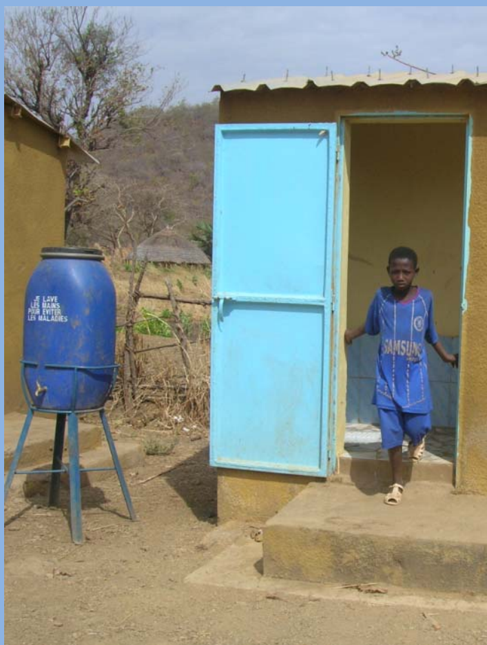
Bloc sanitaire scolaire avec poste d'eau pour le lavage des mains, Sénégal © Eau Vive
