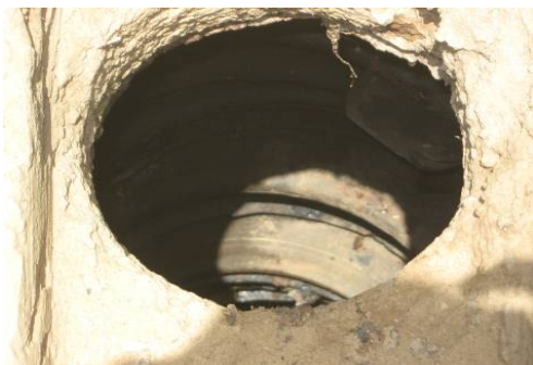
Latrine traditionnelle avec parois stabilisées par des pneus (Ndindi, ZP2)
