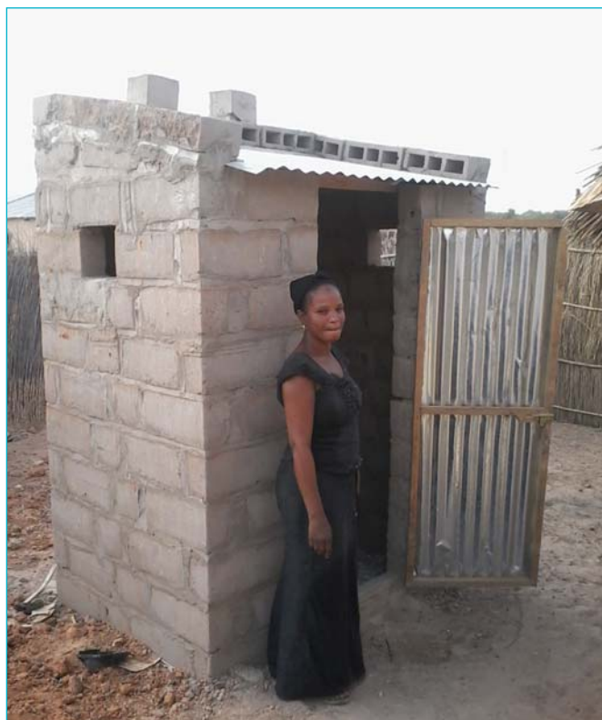
Photo 2 - Latrine familiale dans le village de Mboss, Keur Baka
