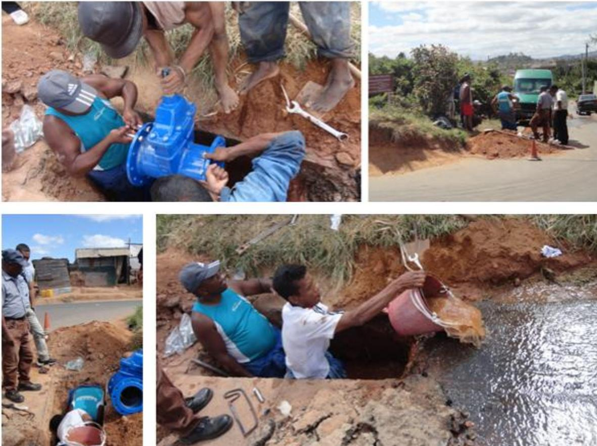
**Illustration 9: Installation d'une vanne de sectionnement à Analamahitsy**
