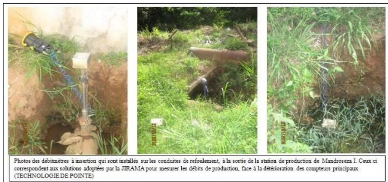
**Illustration 14:** Débitmètres à insertion installés à la sortie de production de Mandroseza I
