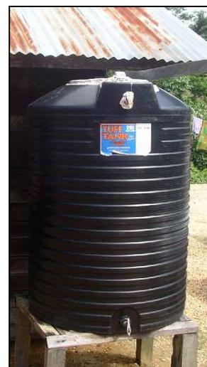
Les deux tiers des réservoirs ont un volume de 2 m<sup>3</sup> et le tiers restant de 1 m<sup>3</sup>. En plus du critère économique, la solution d'un réservoir à hauteur limitée à 1,50 mètre est souvent préférée car l'habitat n'a qu'un seul niveau et les gouttières sont donc basses. S'ajoute à cela que le réservoir est surélevé de quelques décimètres afin de faciliter le remplissage des contenants par le robinet, situé en bas du réservoir.
