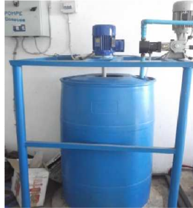
Photo 2 : Pompe doseuse avec pompe Agitateur (Ejeda)
