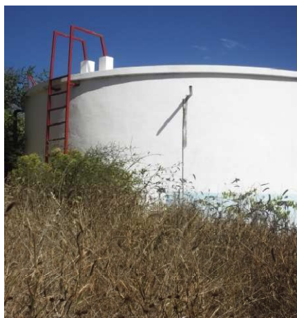
Photo : Réservoir du Site St Augustin
