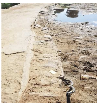
Photo : Tuyau de refoulement non connecté à travers le radier d'Andreasosy.
