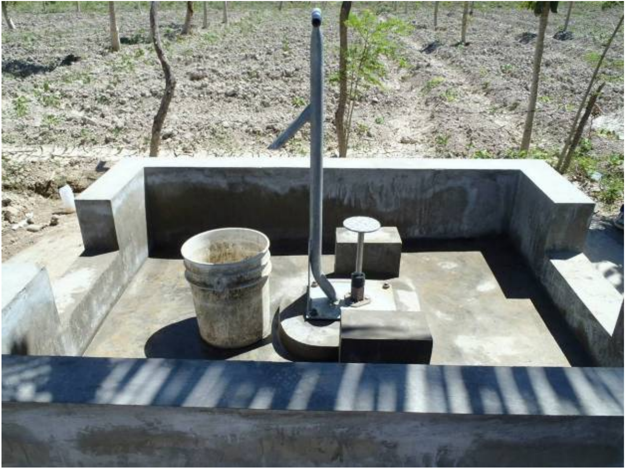
Figure 4 : Exemple de pompe à pédale des environs de Croix des bouquets (modèle Vergnet HPV-60) (Source : Office International de l'Eau, 2012)
