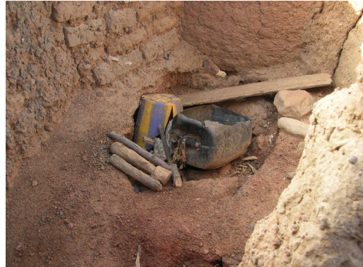
Photo 2 : Latrine traditionnelle effondrée (Nord)
