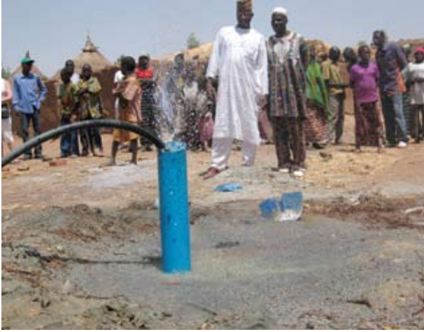
Inauguration d'un forage en 2008.
