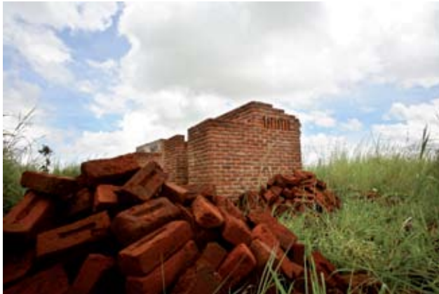
Construction de latrines au Malawi - © Lourdes Segade - Picturetank
