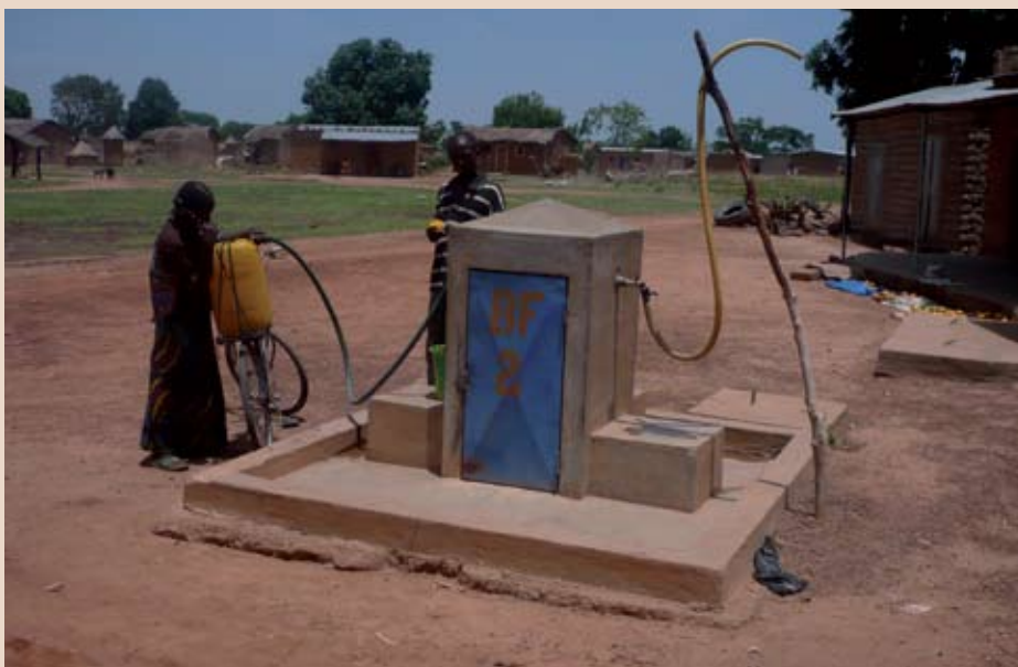
Station service public de l'eau dans la région de Peni au sud du Burkina Faso - © Fondation Veolia Environnement
