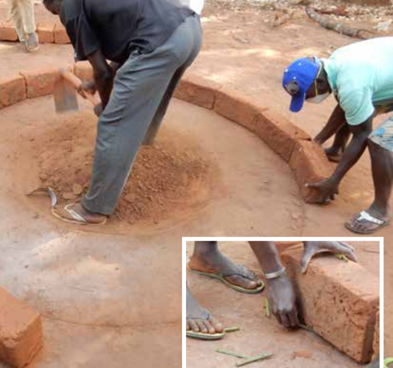
En haut: ajustez les blocs d'argile en position verticale.
