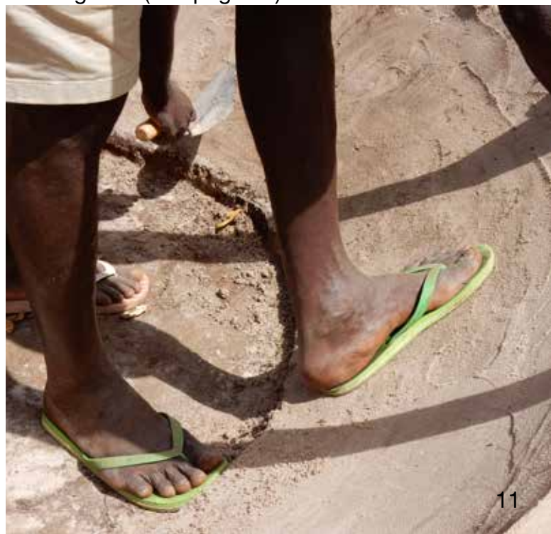
Construction du moule dans le sable mouillé en forme creuse. La forme est nécessaire pour le sol du globe. (voir page 14)
