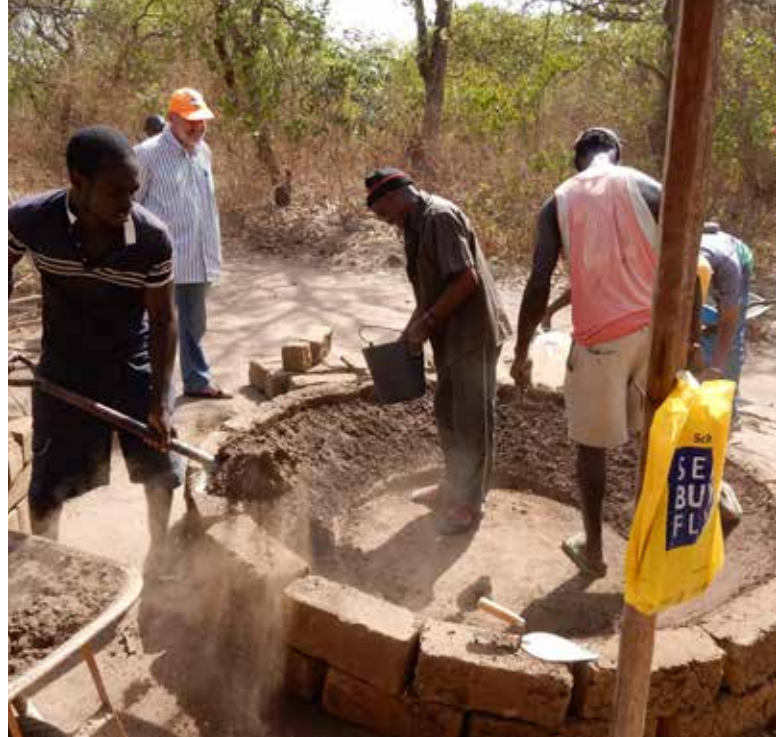
Construction du moule dans le sable mouillé en forme creuse. La forme est nécessaire pour le sol du globe. (voir page 14)
