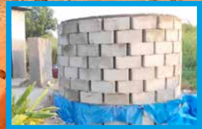
Em outras partes do mundo, blocos de cimento possam ser usados.
