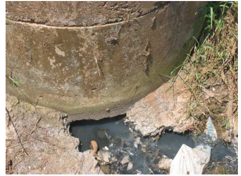
Bassin de décantation en mauvais état
