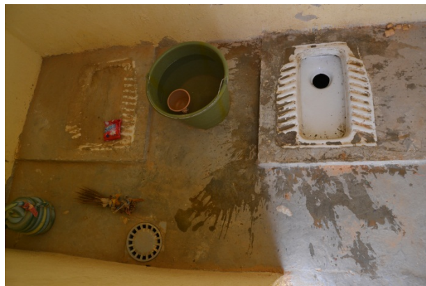
Figure 16 : Les deux fosses sont utilisées en alternance. Le siège à gauche reste fermé jusqu'à ce que la fosse à droite soit pleine. En bas au milieu le drain de la douche qui est relié au puits d'infiltration.
