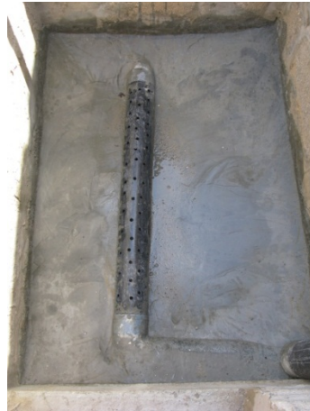
Figure 8 : Tuyau de drainage branché au puits d'infiltration.
