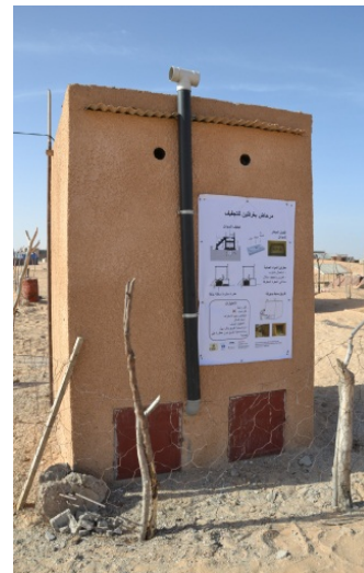
Figure 6 : Exemple d'une toilette à chambres de déshydratation à Nouakchott.
