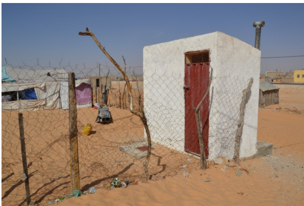
Figure 15 : Toilette à double fosses ventilée à Tarhil, Nouakchott. A gauche de l'entrée se trouve le puits d'infiltration pour l'eau de douche et les eaux grises.
