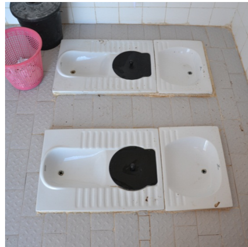
Figure 13 : Sièges à triple séparation préfabriqués, installés au Maroc (un par chambre de déshydratation). Le trou de défécation est fermé par un couvercle en plastique.
