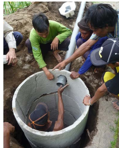
Figure 21 : Pose simple et rapide par empilement des buses préfabriquées en béton. Source: http://mishosoup.wordpress.com/
