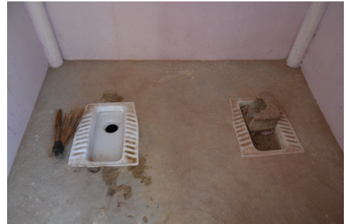
Figure 9 : Les deux fosses sont utilisées en alternance. Le siège à gauche reste fermé jusqu'à ce que la fosse à droite soit pleine.
