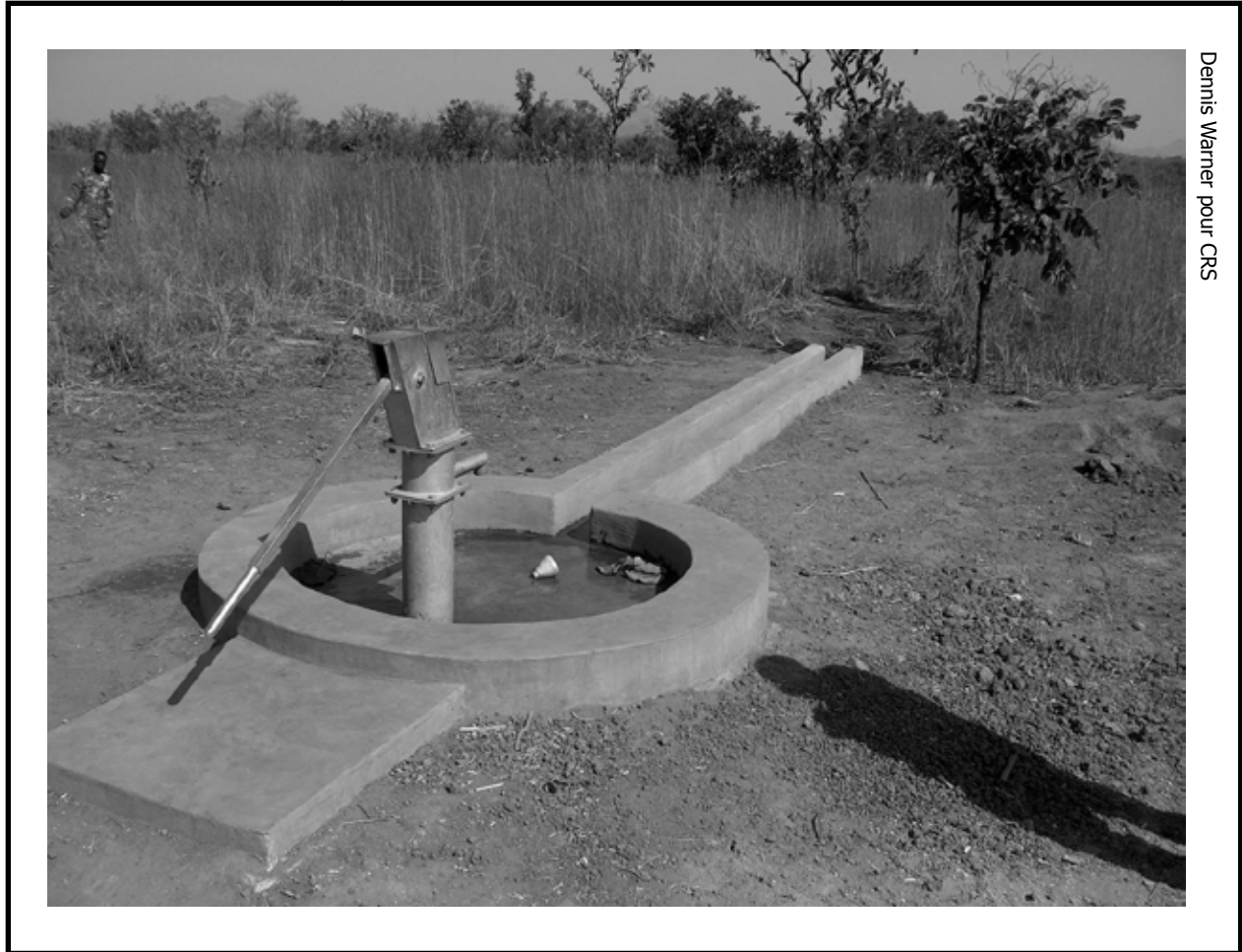
Puits foré au Soudan, installé avec une pompe manuelle, un radier en béton et un déversoir en béton.
