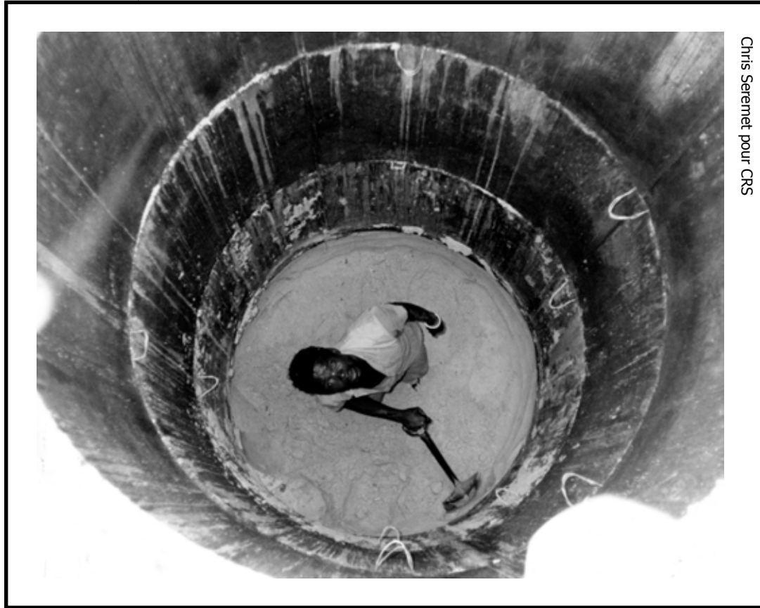
Homme creusant un puits dans un sol sablonneux en Namibie.
