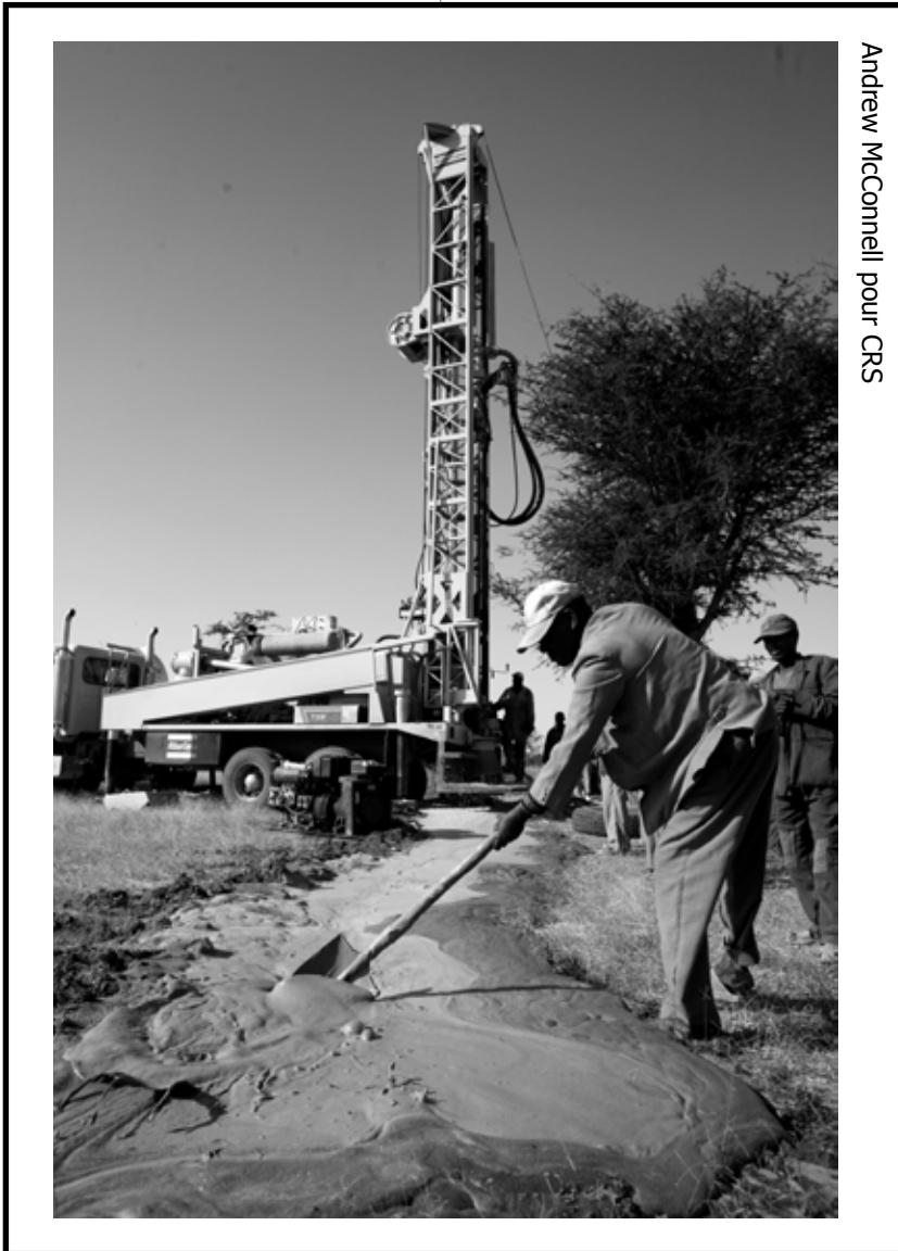
Foreuse rotative utilisant de la boue de forage pour empêcher le puits de s'effondrer en Éthiopie.
