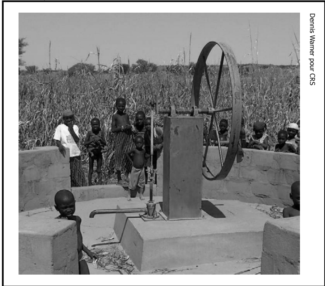
Pompe manuelle Volanta installée au Niger.
