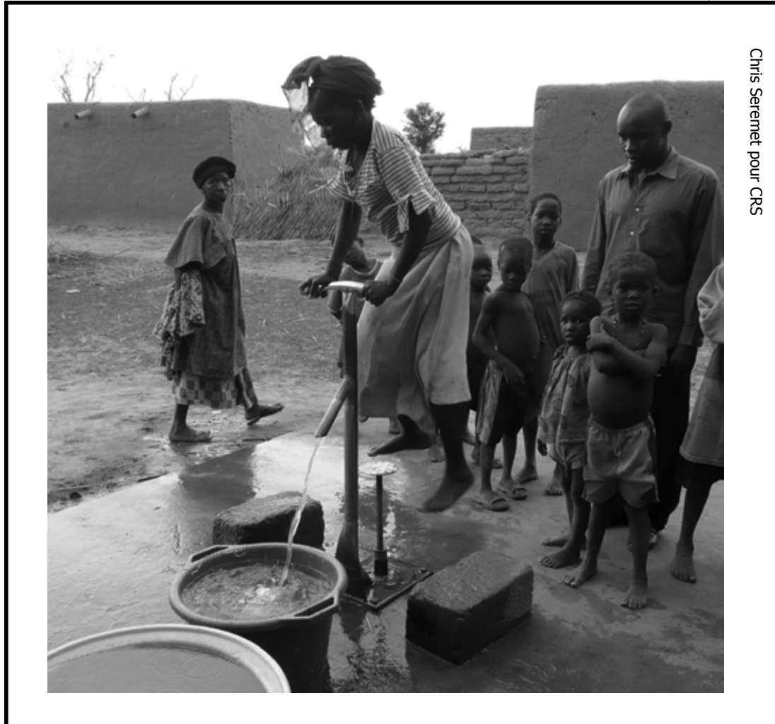
Pompe à pied Vergnet actionnée par une femme au Mali.
