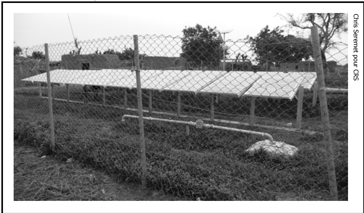
Panneaux solaires alimentant une pompe électrique submersible au Mali.
