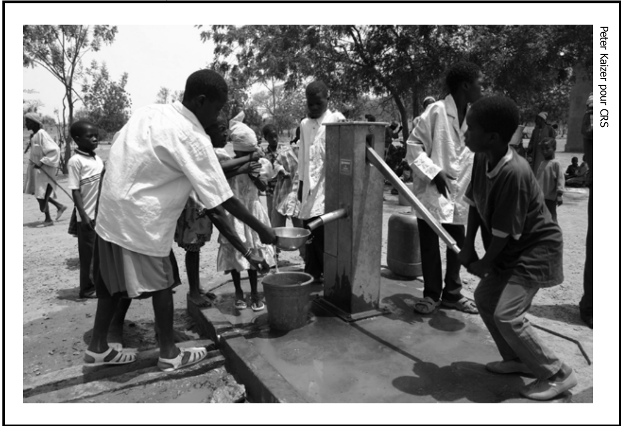
Pompe manuelle servant à alimenter une école en eau souterraine au Burkina Faso.
