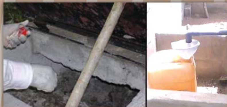
Emplacement du bidon d'urine des latrines ECOSAN
