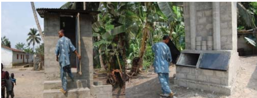
Photo 1: Vue de face et de derrière d'une latrine ECOSAN à double fosses à plaques chauffantes
