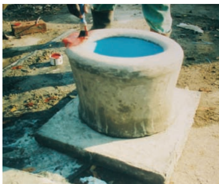
Photo 5-5 : Peinture du siège de béton
