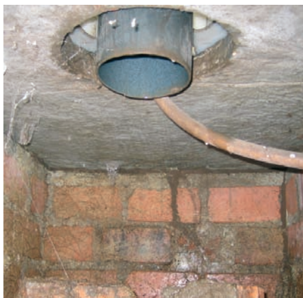
Photo 7-14 : Le tuyau d'urine placé sous la dalle
