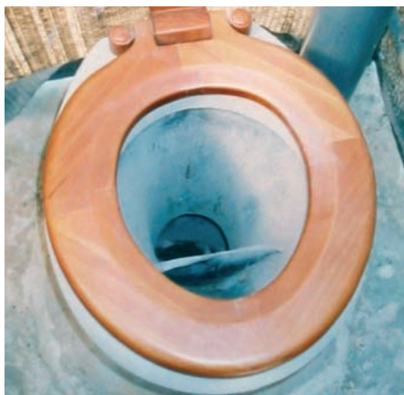
Photo 7-13 : Un siège à séparation d'urines monté au-dessus du sol
