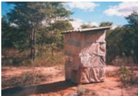
Photo 7-9 : Arborloo construit sur une dalle rectangulaire
