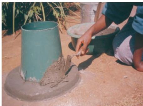
Photo 5-1 : Construction du siège à faible coût.
