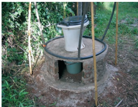
Photo 7-5 : Dalle et siège posés sur une base
