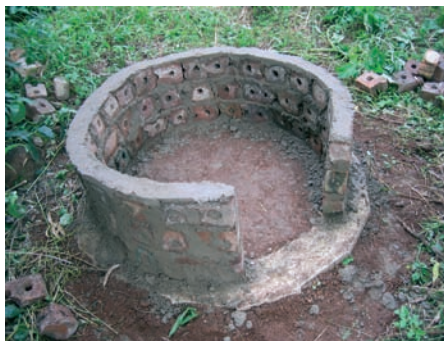
Photo 7-4 : Mur de brique bâti sur le soubassement
