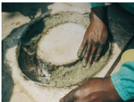
Photo 5-3 : Ajout de béton au moule du siège
