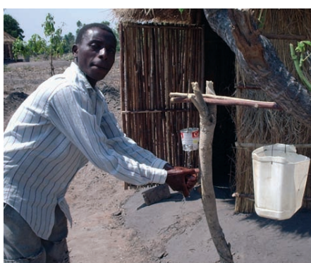
Photo 9-4 : Utilisation du dispositif de lavage des mains simple fait avec une boîte de conserve
