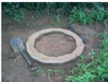
Photo 7-3 : Soubassement posé sur un terrain plat
