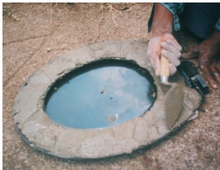
Photo 5-8: Le siège en plastique rempli de béton.
