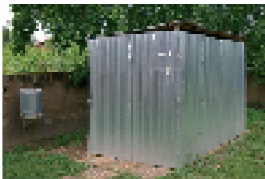
Un bloc de trois cabines avec des "bidurs" pour la récupération des urines
