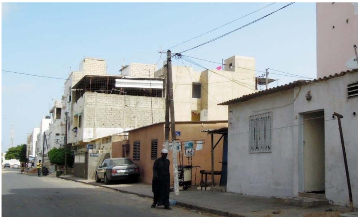
Ci-dessus et ci-dessous : vues d'une rue d'un quartier d'habitat planifié (zone biscuiterie/ HLM, nord de Dakar). Les maisons basses de l'origine servent de base à la réalisation de maisons, voire d'immeuble de plusieurs niveaux. Crédits : CRAterre.
