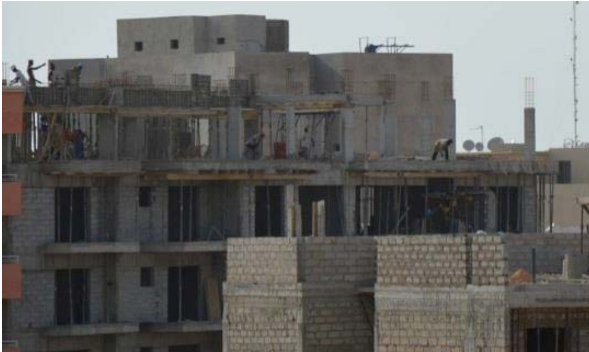
Ci-dessus : chantier d'un bâtiment en bloc ciment à Dakar. Crédits : CRAterre. 2014
