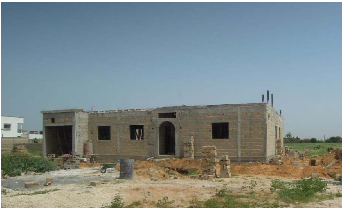
Ci-dessus : Chantier d'une maison basse
