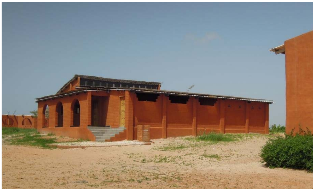
Ci-dessus : Village pilote, construction en BTS
