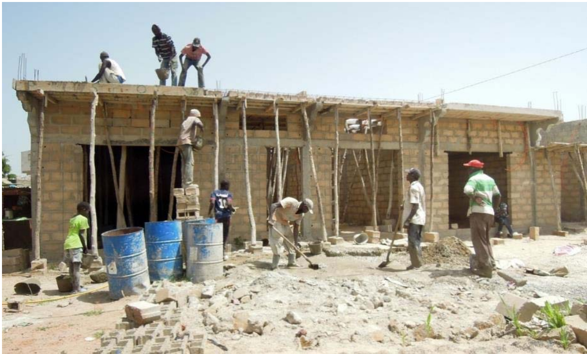
Ci-dessus : Chantier d'une maison basse en ossature béton armé et agglomérés de béton le long de l'axe Dakar –Thiès. Crédits : CRA-terre.
