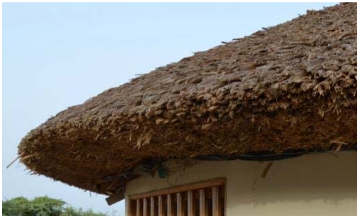
Ci-dessus : toiture en chaume de typha du site Afrika Madela Ranch, association TypHAS. La durabilité de cette toiture sous les conditions climatiques locales devrait être 2 à 4 fois plus grande que celle des toitures en paille. Crédits : CRAterre, 2014.
