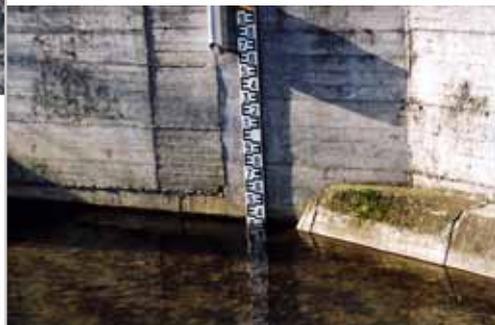
◀ Échelle limnimétrique à ultrasons pour l'enregistrement en continu du niveau de l'eau et permettant d'établir sa relation avec le débit d'un cours d'eau.
