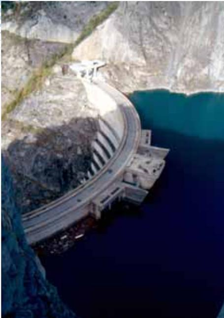
▲ Vue du paravent aval du barrage-voûte du Monteynard de l'aménagement hydroélectrique EDF du Drac (Isère). Hauteur et volume du barrage, 153 m et 457 000 m<sup>3</sup>, respectivement. Volume de la retenue : 275 hm<sup>3</sup>.
