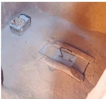
*Une série d'innovations a été faite pour éviter la contamination avec des mouches, comme ce couvercle en bois avec une manche, avec une boîte à cendre juste à côté et une pelle fabriquée à partir d'une bouteille en plastique. Le nombre de latrines avec ces mêmes caractéristiques construites par les communautés cibles du programme a atteint 31507 vers la fin de Décembre 2013.*
