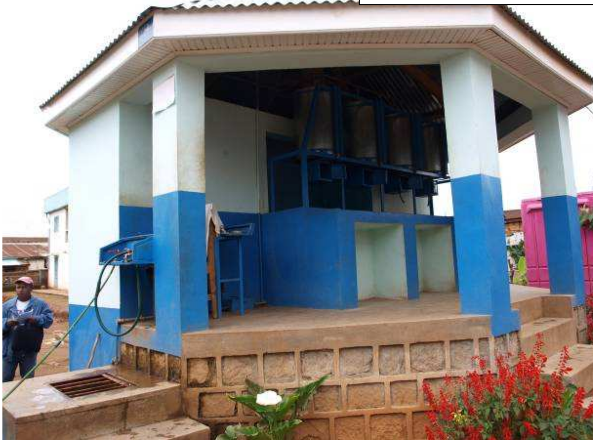
Distribution d'eau potable depuis un kiosque à eau (gestion privée Sandandrano)
