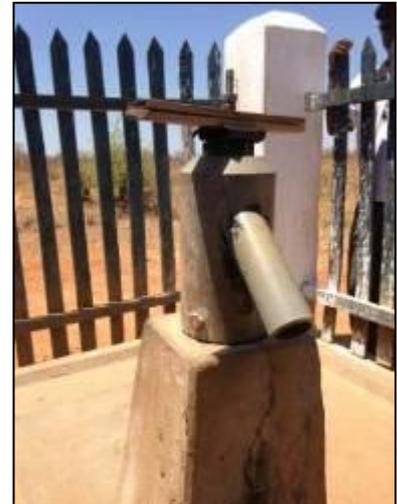
Pompe de type canzee (développée localement par BushProof)
