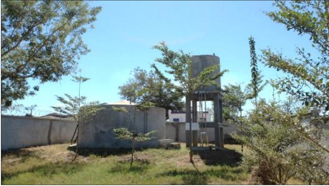
Photo du réservoir d'eau
