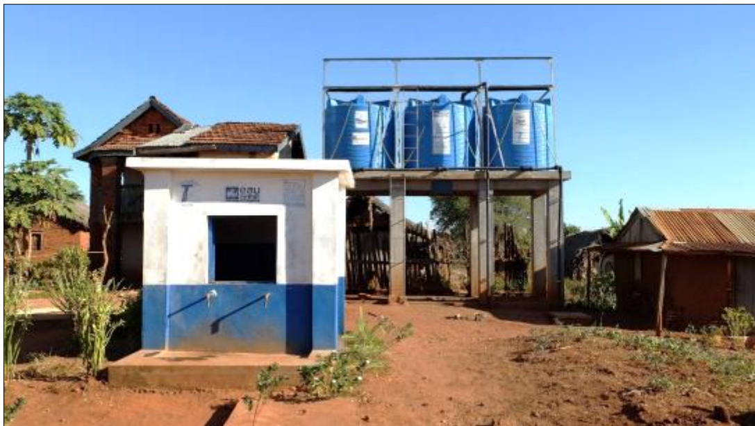
Photo d'un kiosque et de 03 réservoirs en plastiques de 5 m 3
