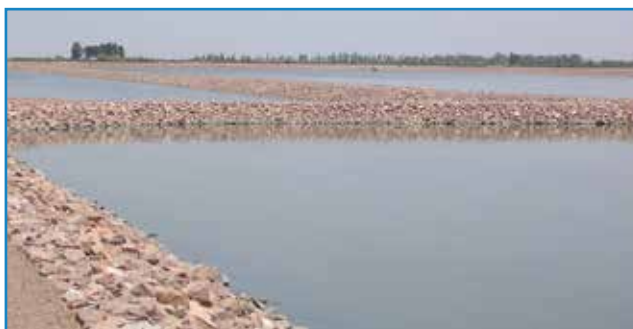
Lagunes de traitement Settat (Maroc) – Mayaux ICID 2015
