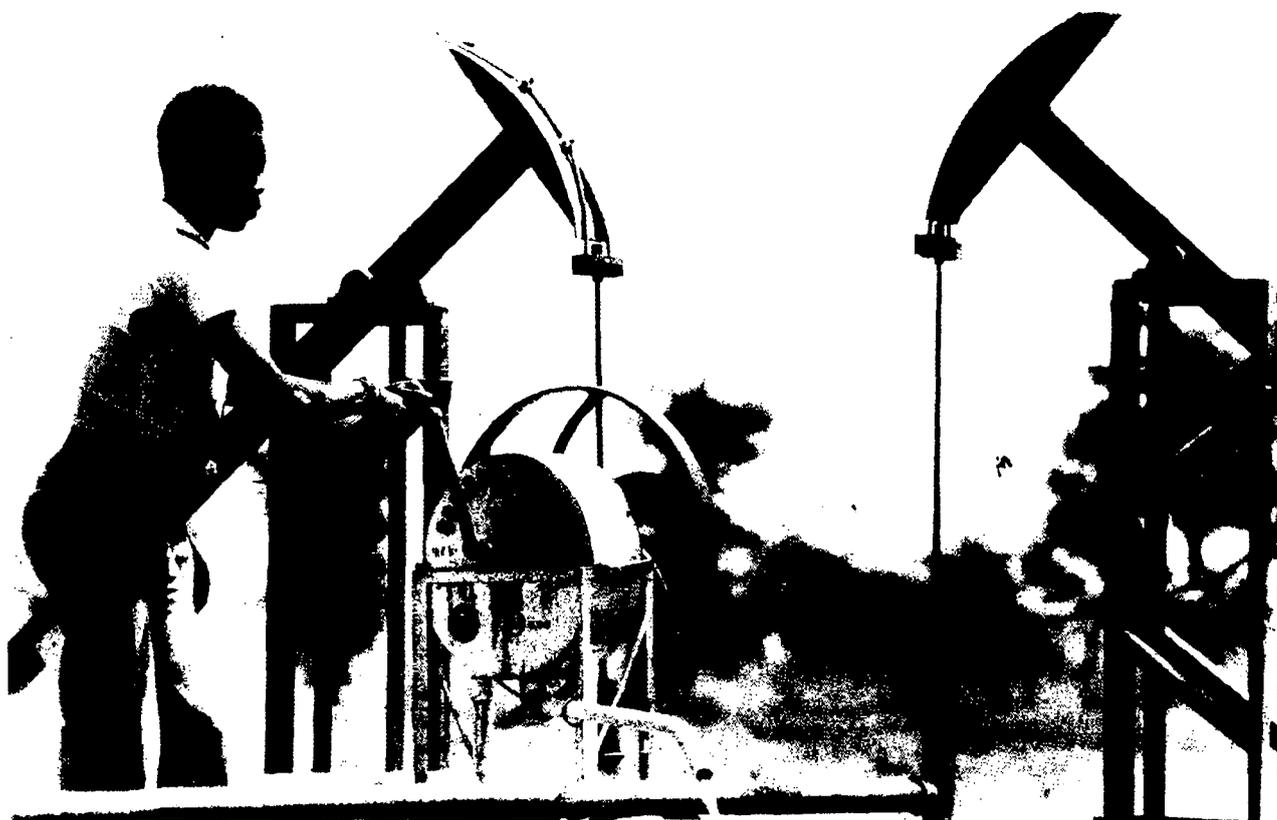
**SOUSSANE (Sénégal)** — Deux pompes à piston GUEROULT et une pompe à chaîne installées sur un même puits.
