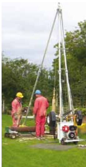
Figure 4. La machine de forage au câble Forager 55 en action
