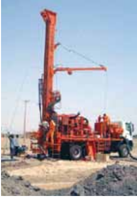
Figure 7. La foreuse Watertec 24 de l'entreprise Dando
