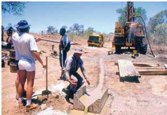
Figure 15. Mesure du débit de purge d'un nouveau forage
