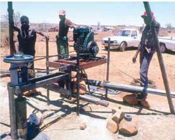
Figure 17. Machine pour essai de pompage consistant en une pompe à rotor (Mono) actionnée par une courroie, Zimbabwe
