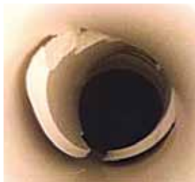
Figure 18. Dommages au tubage tels qu'ils apparaissent filmés par une caméra en circuit fermé
