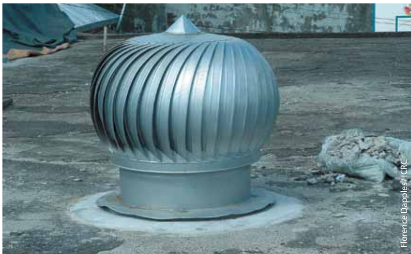
Figure 11 Exemple de système simple de ventilation par le toit permettant l'évacuation de l'air chaud et humide
