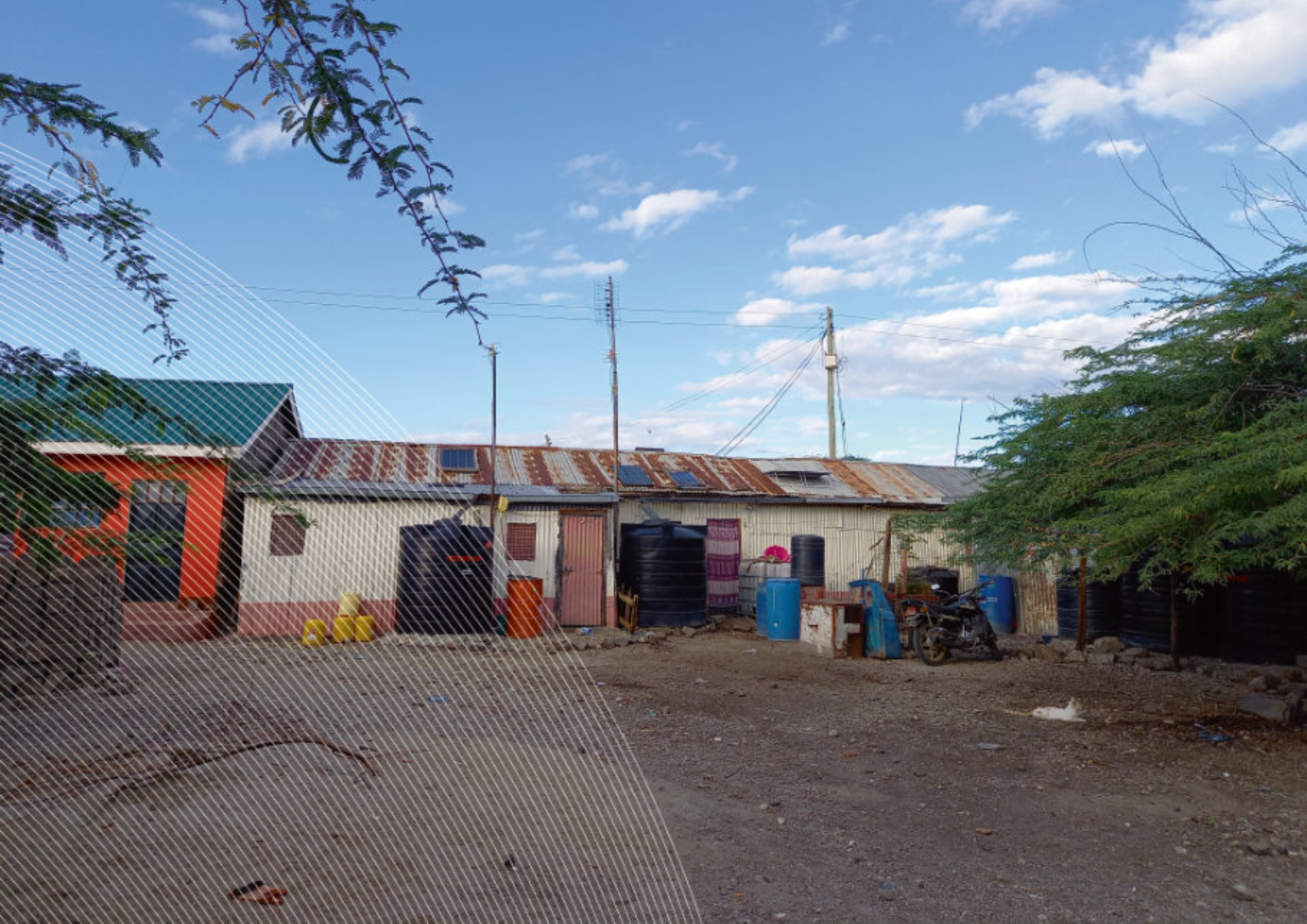
Des panneaux solaires individuels compensent le manque d'électricité du mini-réseau © Émilie Étienne 2022
