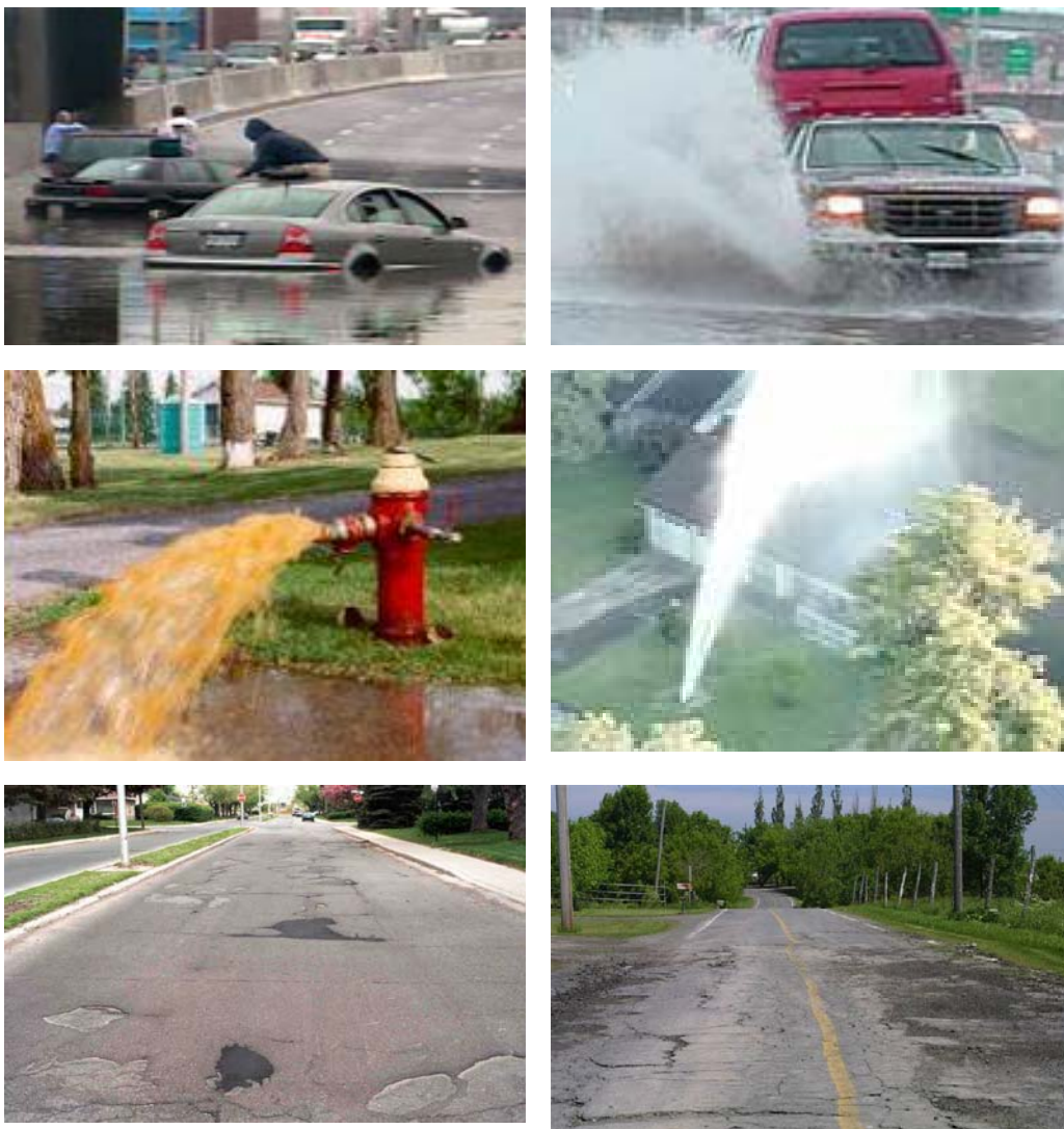
Figure 10 : Exemples de déficiences indicatrices du niveau de service des infrastructures municipales
