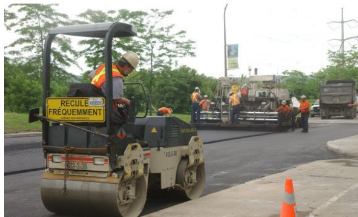
Figure 9 : Travaux de réhabilitation d'une chaussée
