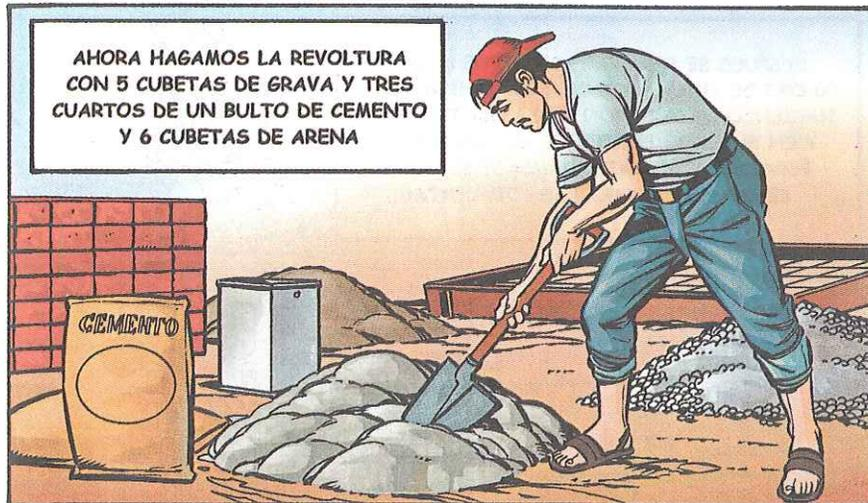
CUANDO ESTE LISTA LA REVOLTURA, SE PROCEDE A COLOCAR PARA FORMAR LA PLATAFORMA DE ARRANQUE DE NUESTRO SANITARIO.
