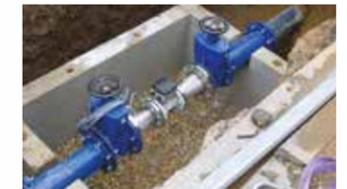
Les vannes ont pour fonction d'isoler le comptage du réseau pour permettre son remplacement ou une intervention en cas de panne. Il est prévu également des bouches à clé pour pouvoir les actionner.
