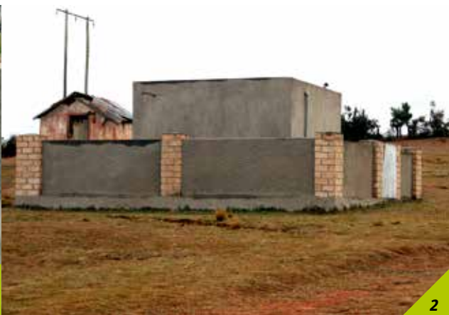
2 - Réservoir d'eau de 15 à 30 m³
