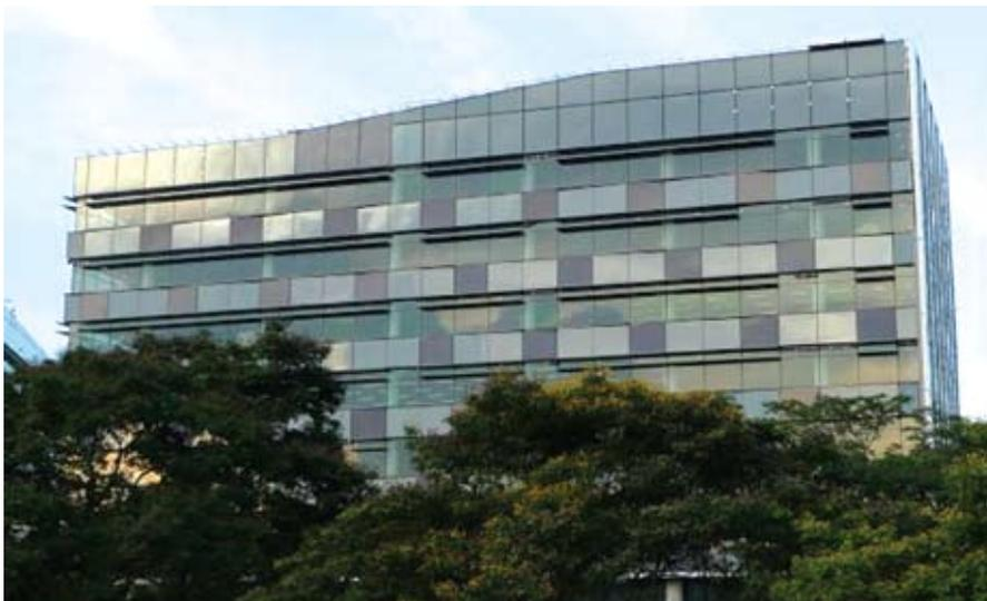
**Figure A.8.1. 6kWp BIPV façade on Tower 2**
