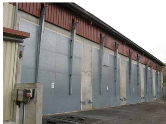
Installation de méthanisation à la ferme de M. Siegfried Schneider à Kussel.
