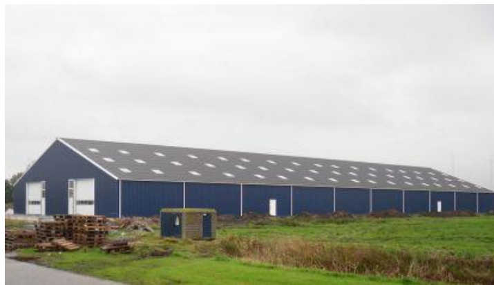
Figure 9: Exemple de hangar métallique fermé muni de sas. Ce hangar par exemple possède deux compartiments avec chacun une porte. Des matières différentes peuvent donc être stockées dans chaque compartiment. Source : http://www.hangars-metalliques.fr
