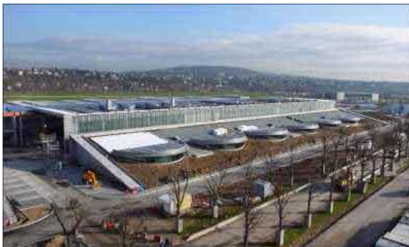
Figure 12 : Dans l'unité de traitement des pollutions azotées de la station d'épuration de Seine Aval (SIAAP), les flotateurs de boues sont munis de couvertures planes. Source : www.vinci-construction.fr
