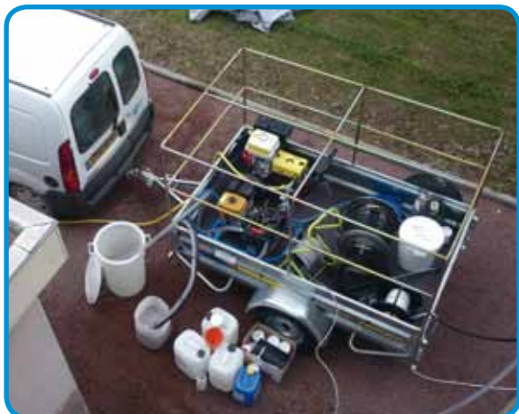
Remorque équipée : pulvérisateurs haute et basse pression, tuyaux, produits et accessoires. L'ensemble reste à l'extérieur du réservoir.
