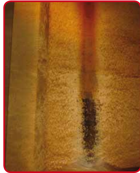
Concrétions calcaires
