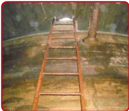
Échelle vétuste, aucune protection
