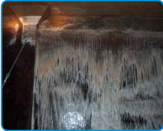
Solubilisation de dépôts importants de fer et de manganèse
