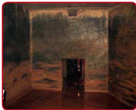
Dépôts fer - manganèse
