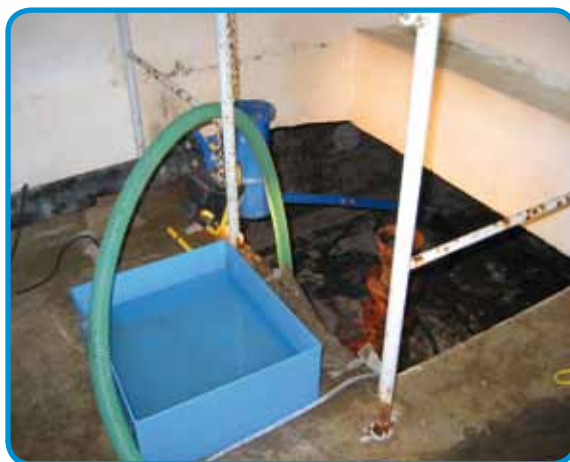
Pédiluve rempli de solution désinfectante
