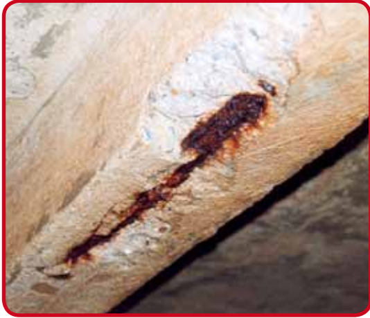
Poutrelle érodée, armature à nu
