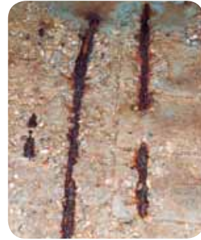
Poutrelle érodée, armature à nu
