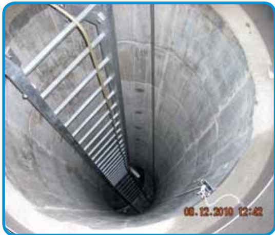
Sécurisation d'un ouvrage de grande hauteur
