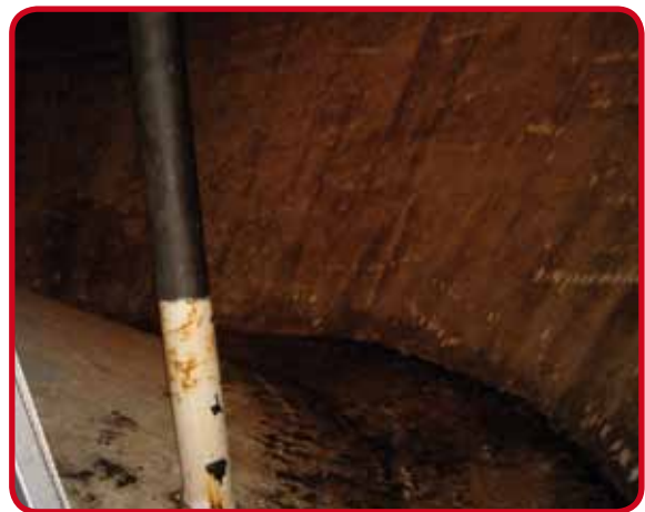
Revêtement époxy, photo B
