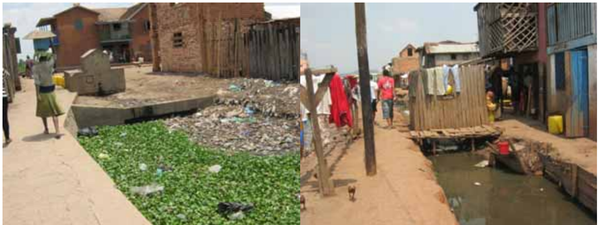
Dalot du canal C3 au Nord du fokontany, quasiment bouché par les déchets et la végétation
