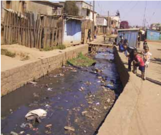
Rétrécissement du canal à Avaradoha
