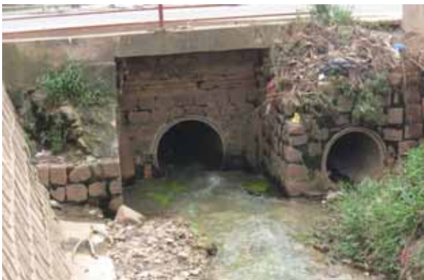
Ouvrage de franchissement à Ampahibe au niveau du collecteur principal
