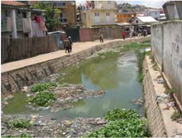
Exutoire du bassin tampon, sous le pont d'Anosibe
