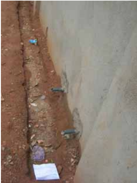
Rejet direct des eaux usées dans un caniveau en terre proche de la ruelle
