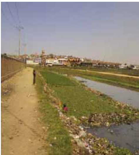
Cressonnières dans le collecteur principal à Manjakaray
