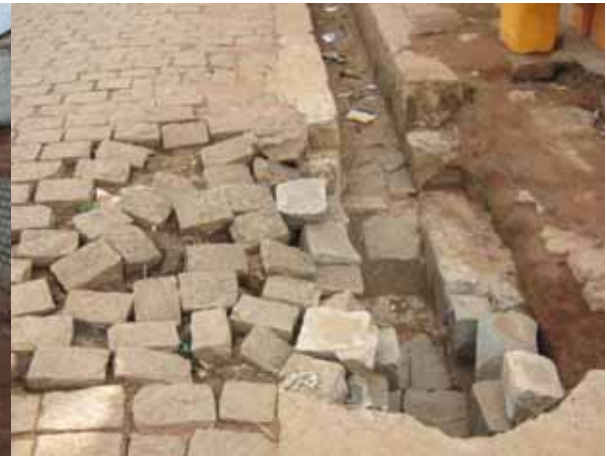
Début de dégradation du réseau à Ankadindravola Est
