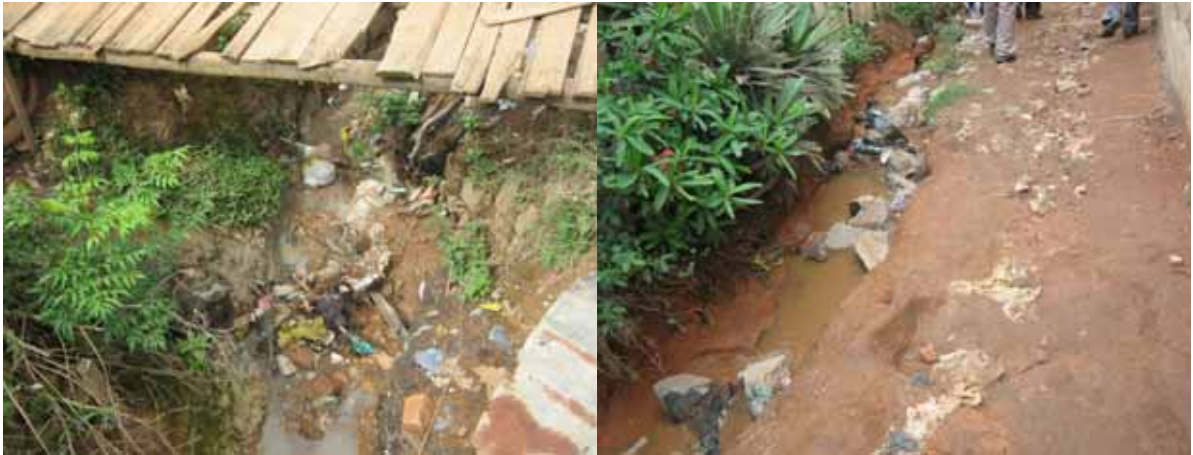
Erosion importante dans le secteur 7 sur le chemin préférentiel des eaux de ruissellement
