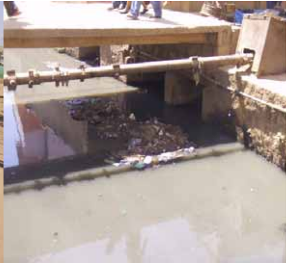
Sortie du canal d'Avaradoha-Besarety vers le collecteur principal
