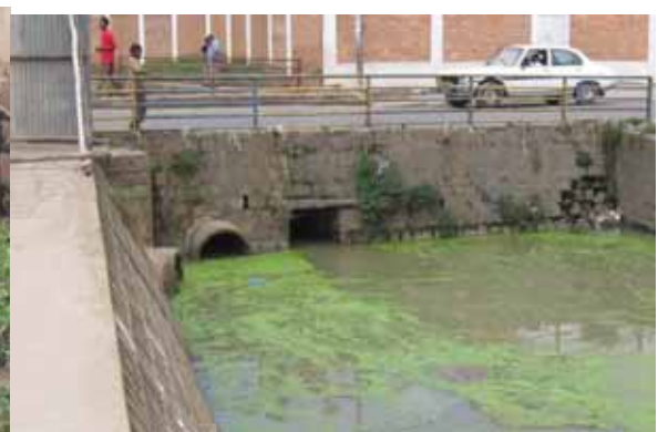
Partie aval de l'ouvrage de la rue Rasoamaharo
