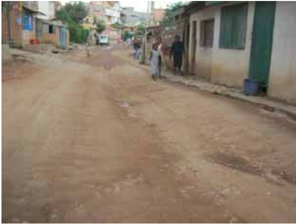
Niveau de la route situé au-dessous du réseau d'assainissement et zone de stagnation d'eau
