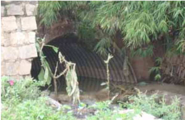
Buse Armco sur la route de Tsiadana
