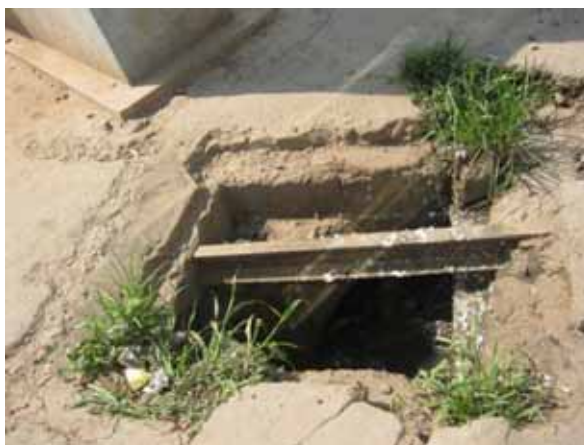
Regard complètement détruit près du centre commercial Prisme
