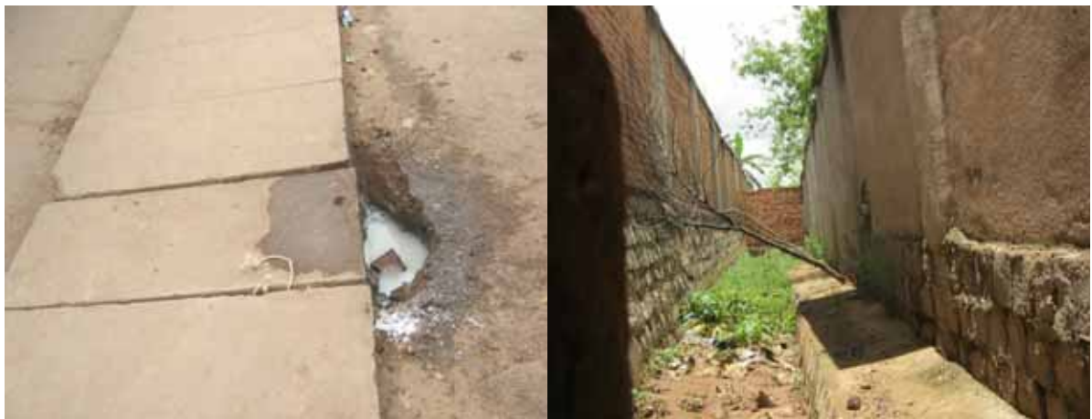
Caniveau devant la commune sur la route principale, détérioré par les riverains
