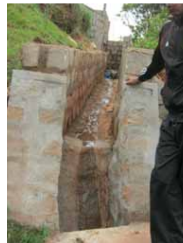
Sortie de caniveau, en saison des pluies, les eaux ne s'écoulent pas dans le regard mais passent au-dessus
