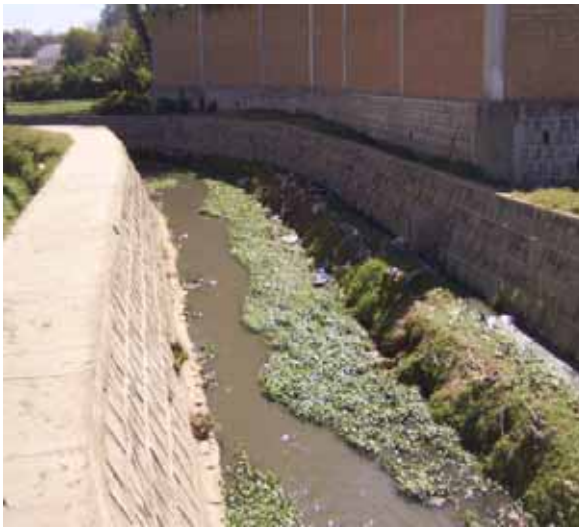
Rétrécissement du canal
