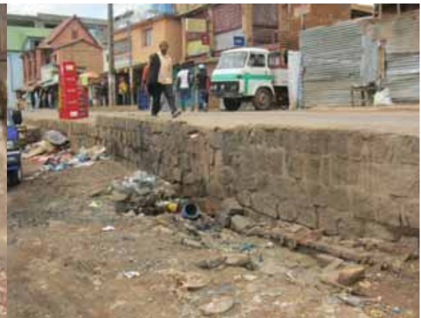
Regard bouché par les déchets
