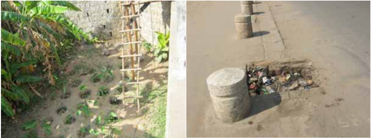
Lieu d'évacuation d'une buse remblayé par des riverains
