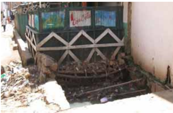
Dépôts entassés en dessous d'une construction sur un canal et des conduites d'eau de la JIRAMA
