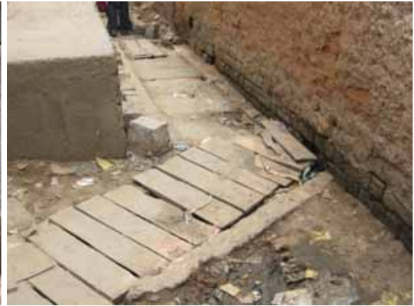
Caniveau en très mauvaise état, complètement bouché
