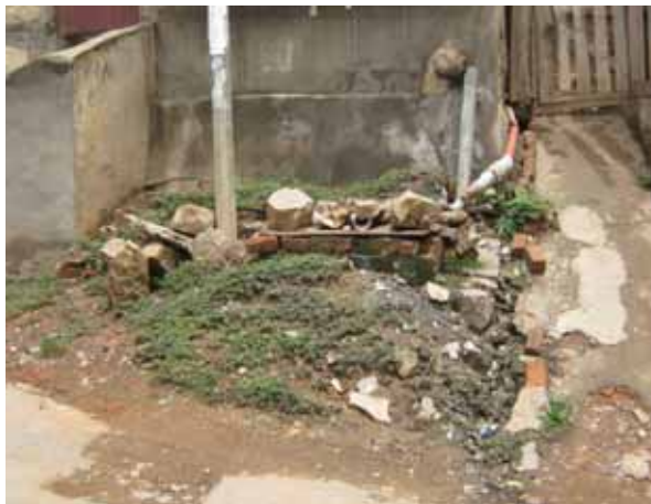
Puisard en bord de route
