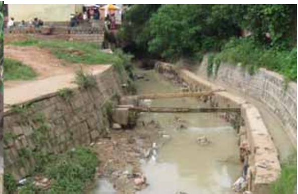
Canal amont de la buse Armco en mauvais état
