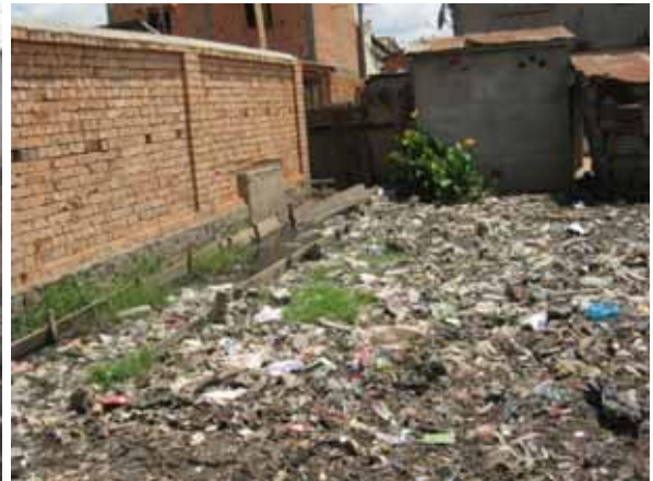
Canal d'évacuation entourée de déchets
