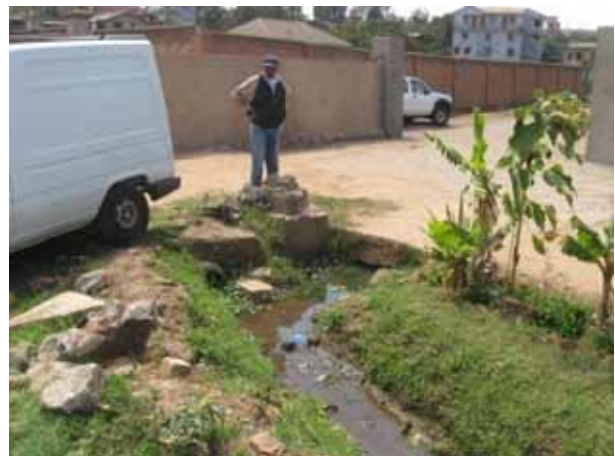
Jonction des deux caniveaux dans l'enceinte de l'hôtel Tournesol
