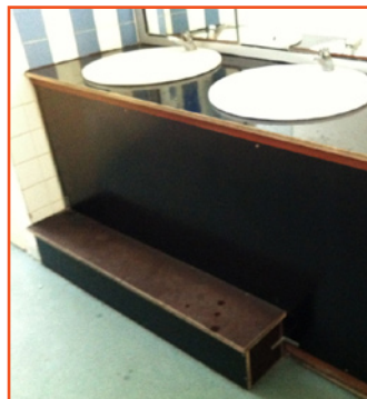
Les différences de tailles des enfants de l'école élémentaire ont été prises en compte. Une estrade a été aménagée, permettant ainsi aux plus petits d'accéder facilement aux robinets
