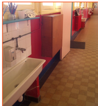
Lavabos en sortie de classe, dans le couloir (école primaire).
