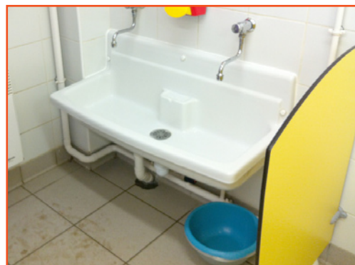
Lavabos dans les sanitaires des classes de la maternelle. Les deux robinets sont coincés entre la porte, la cloison d'un urinoir et la poubelle.
