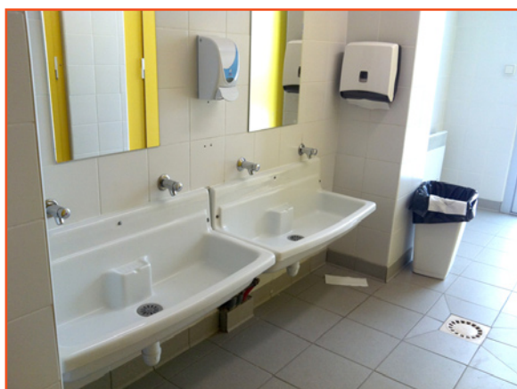
Lavabos dans les sanitaires des classes élémentaires fixés à la même hauteur que ceux des classes de la maternelle. Adapté pour les plus petits, un peu moins pour les élèves des cours moyens.
