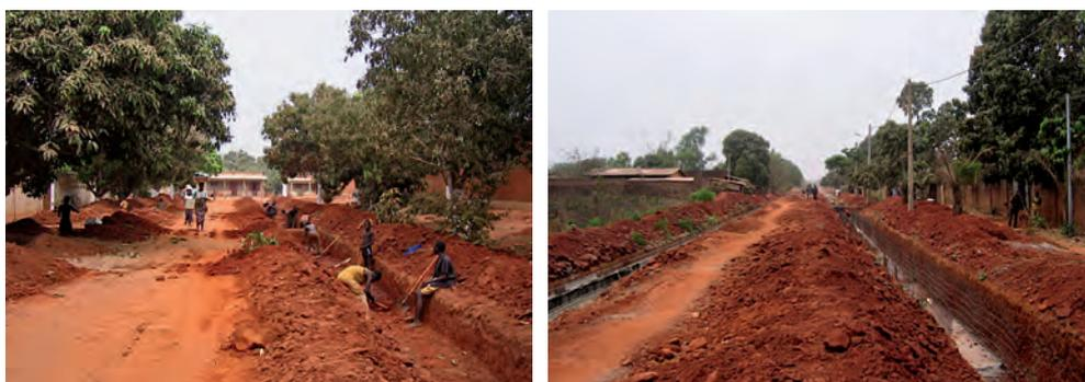
*L'aménagement d'une voie principale d'Abomey (pavement, construction de trottoirs et caniveaux d'évacuation des eaux usées).*
