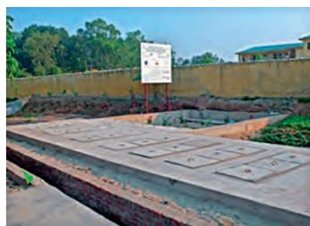
*Procédé en cours d'expérimentation, le Dewats repose sur 4 principaux modules de traitement (un décanteur-digesteur, un réacteur et des filtres anaérobiques, un filtre planté végétal) qui restituent en sortie une eau propre à la consommation.*
