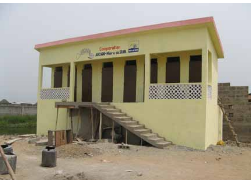
Latrine scolaire en zone inondable Partenariat ARCADE / Orvault / So Ava
