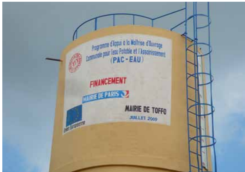
Château d'eau d'une des AEV
