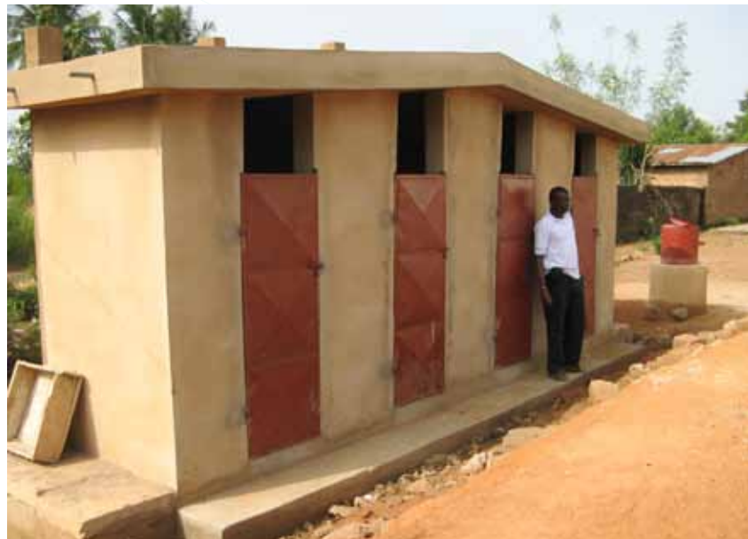
Latrines scolaires avec lave-main
