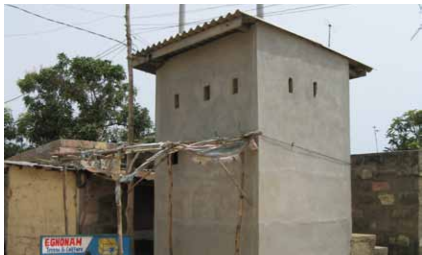
Latrine surélevée en zone inondable (Cotonou)
