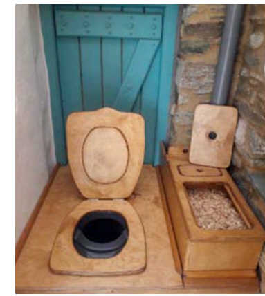
Toilettes sèches (photo Eric MINO, HYDROUSA ou SEMIDE, à préciser)
