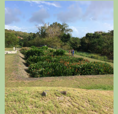
Etage de filtres plantés de végétaux en Martinique (crédit photo INRAE)
