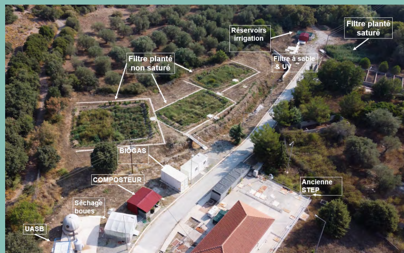
Implantation du système d'assainissement
