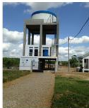
Ex photographie de la station
