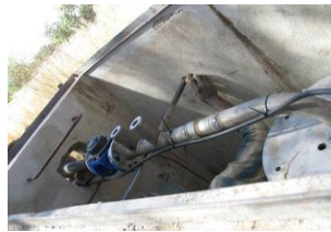
Crépine de la pompe placée à moins 41 m du point zéro
