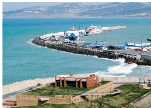
Nouvelle usine de traitement des eaux usées
