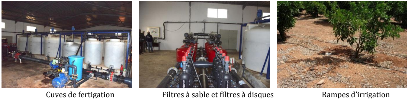
Figure 12 : schéma d'un système d'irrigation goutte à goutte au niveau d'une exploitation agricole de la plaine des Triffa (Berkane, Maroc oriental).
