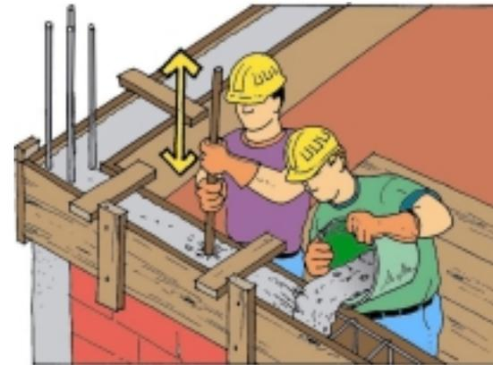
El concreto de las vigas y columnas debe mantenerse húmedo y protegido del sol y el viento al menos durante los primeros 7 días después de vaciado. El curado del concreto es fundamental para garantizar una buena calidad y resistencia del material a largo plazo.
